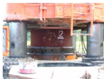
図-6.二重ケーシング状況
