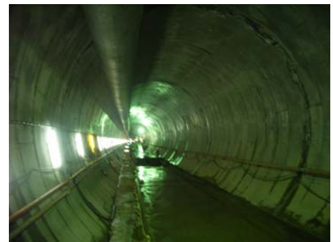
図-6 一次覆工コンクリートの状況
