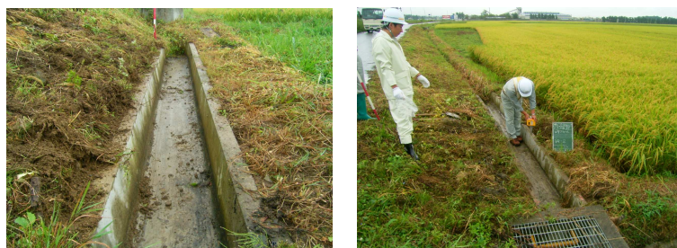
写真-2 現場状況 (小牛田バイパス)
