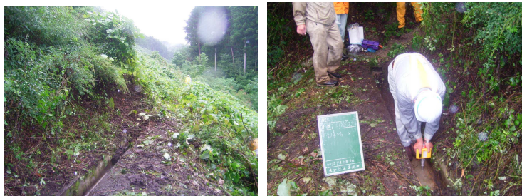
写真-1 現場状況 (山田道路)
