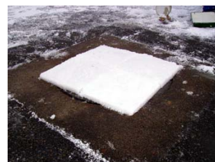
(c) マンホール上の圧雪設置状況
