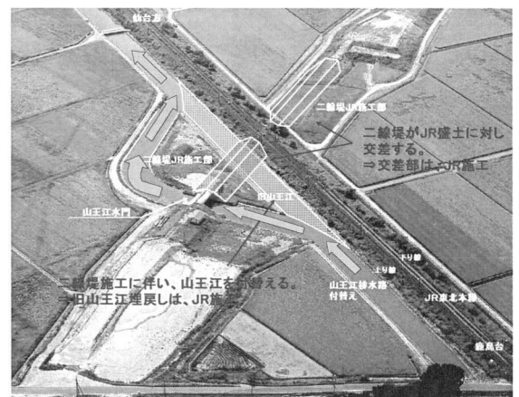
図-2 二線堤交差部状況
