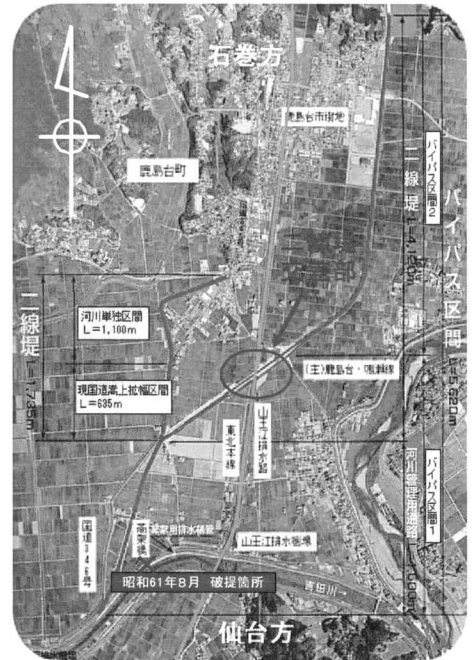
写真-1. 交差部付近 航空写真
