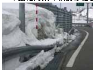
a)切土端部状況
