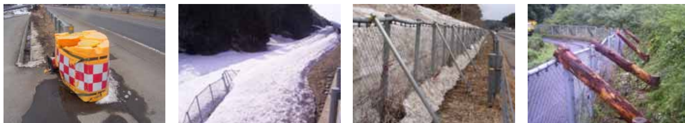
a)分岐端クッションドラム破損
