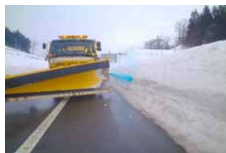
写真-4 ブルーライン作業状況
