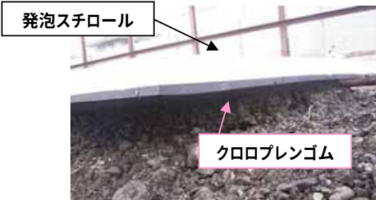
図-4 杭頭部施工状況
