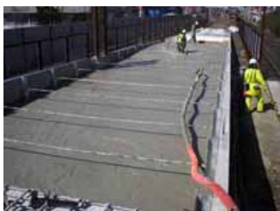
図-5 打設状況写真
