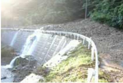
写真 1 県道への土砂流出状況
