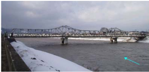
写真1 大橋側面 (橋長 147.55m, 幅員 5.5m)
