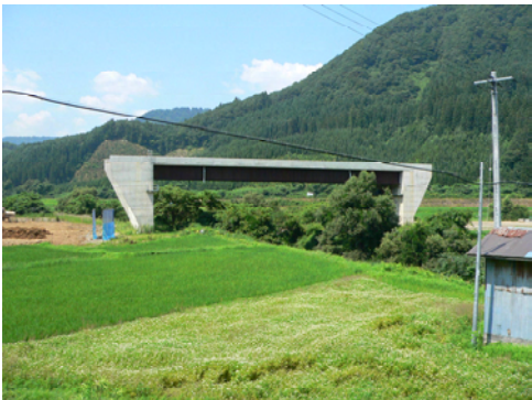
写真-1 中田春木川橋全景
