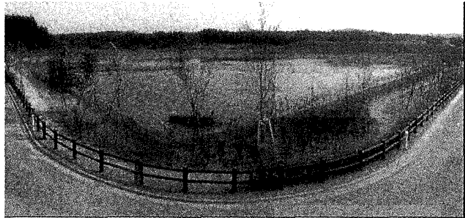
写真-2 南側沈殿池改修後状況
