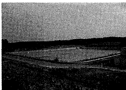
写真-1 南側沈殿池
