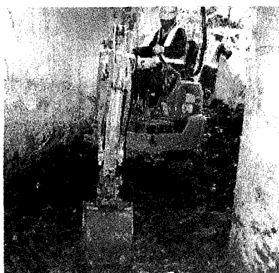
写真-3 狭小部構造物掘削
