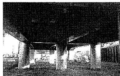
図-6 先行施工部脱型後
