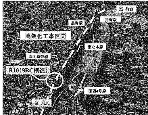
図-1 長町高架化施工箇所
