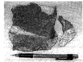
図2 レンガと目地モルタル
