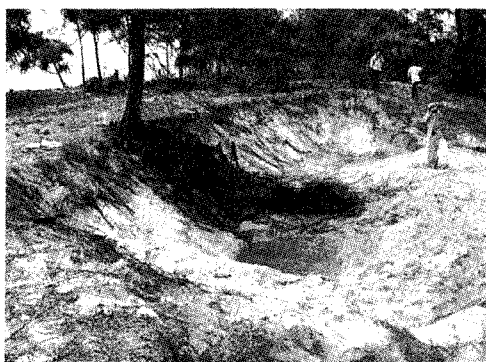
写真-1 浜堤に発達したスランプ型崩壊地形
