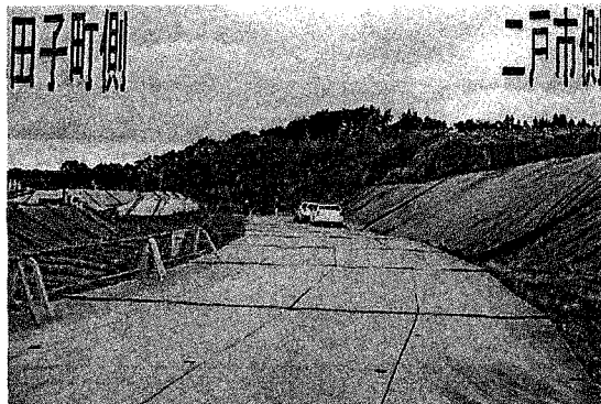
写真1 青森・岩手県境廃棄物処分地における雨水浸透低減のためのキャッピングシート （中央の道路が県境、両側のキャッピングシートの下に不法投棄された廃棄物）
