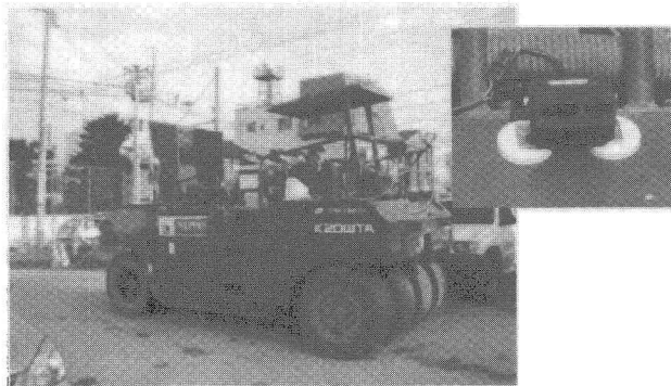
写真－1 超音波センサー取付状況
