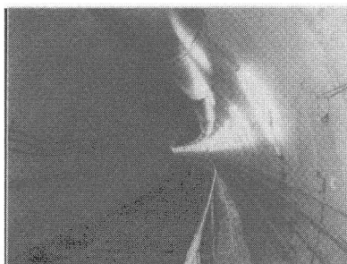
写真 坑内全景
