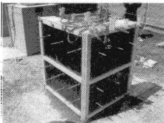
写真1 養生シートによる湿潤養生
