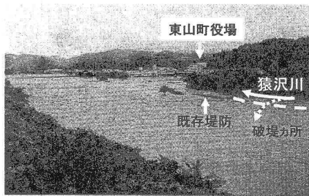
写真-2 猿沢川左岸（本町橋下流約20m地点）の破堤（資料提供：東山町役場）
