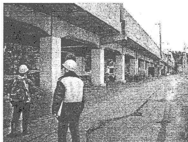
(a) 耐震補強された高架橋近景
