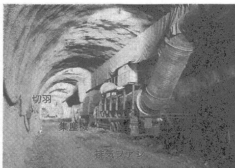
写真-1 切羽換気状況
