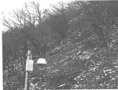
写真-3 対策工状況
