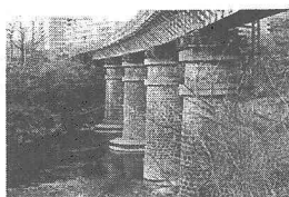
写真-1 補強前の橋脚
