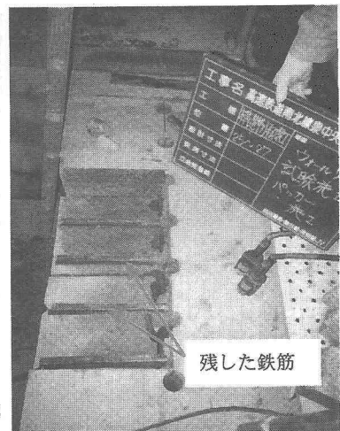
写真-1 上段ブロック取壊し状況
