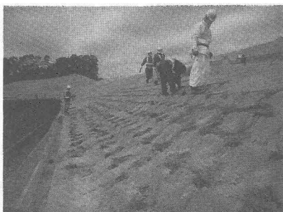
写真-3 植穴削孔・地被類植付状況
