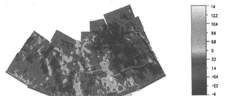
図-3.「膨潤性岩吹付のり面」温度差画像例
