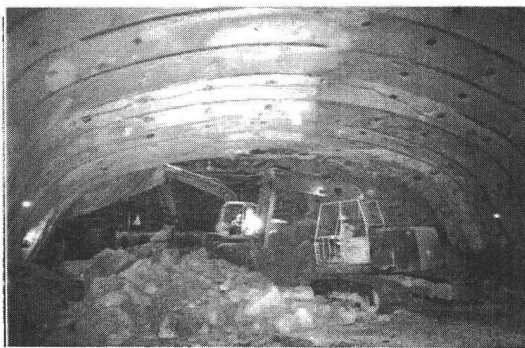
写真-1 ドラフトトンネル貫通状況
