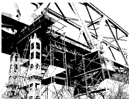
写真－１ 部材交換の作業風景
