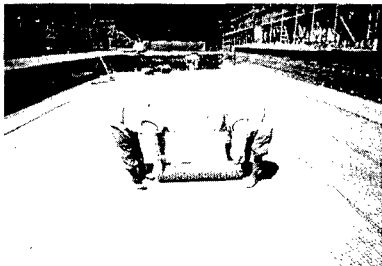
写真-4 岩沢跨高速道路橋における施工状況
