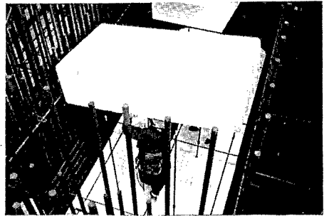
写真-2 E P S 型枠による施工状況
