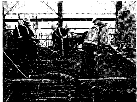
写真－1 打設状況
