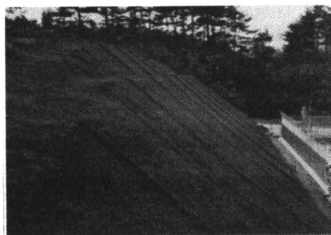
写真 1 施工後 43 日の法面状況
