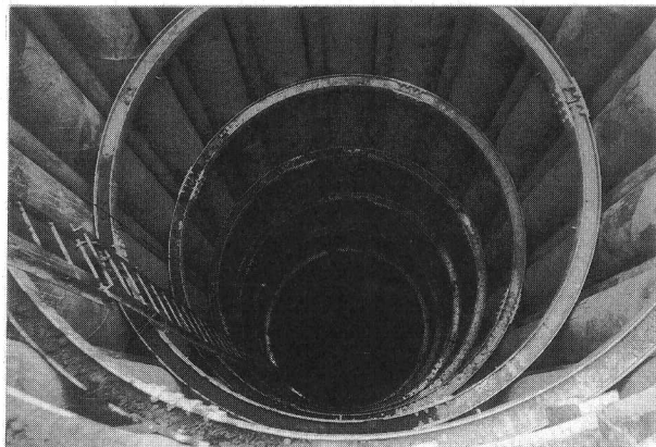
平根地区第23号集水井完成写真
