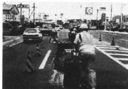
写真-1 従来工法（人力施工）
