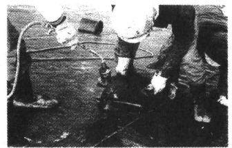
アスファルトシートの 融着作業状況
