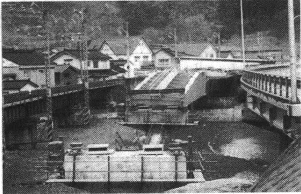
写真-4 施工中の「新岩川大橋」
