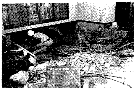
写真-1 家屋下布基礎取り壊し状況
