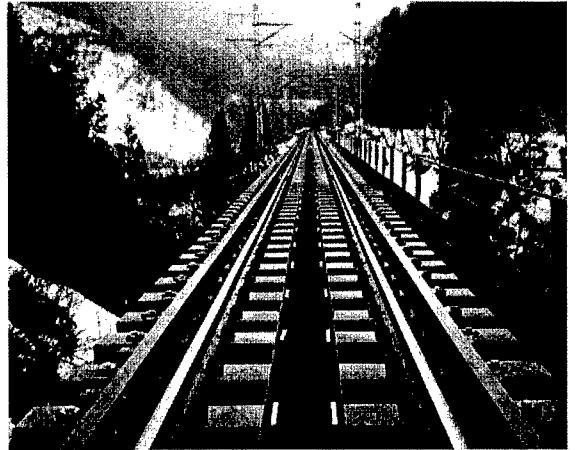
図1 無道床鋼桁鉄道橋
