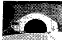
写真-1 4 柿崎TN 面壁型(アーチウィング式)
