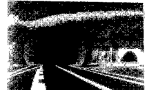
写真-2 9 関越TN 突出型(逆ベルマウス式)
