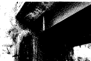
写真-2 B橋橋台劣化状況
