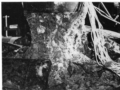
写真-4 二重管構造試験体破壊形状
