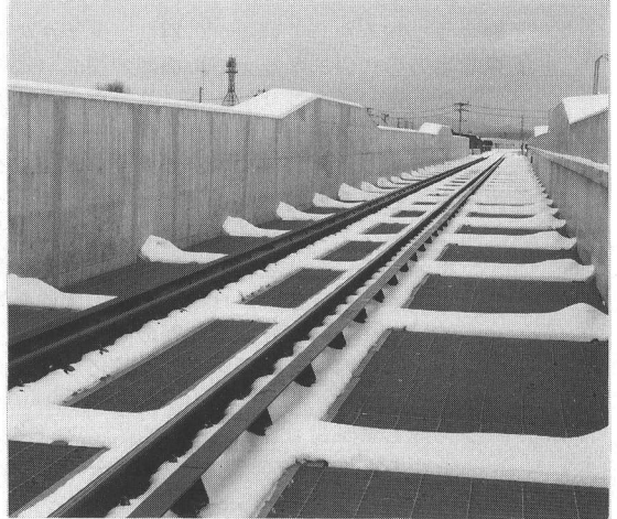
写真-2 積雪状況 97.1.23.
