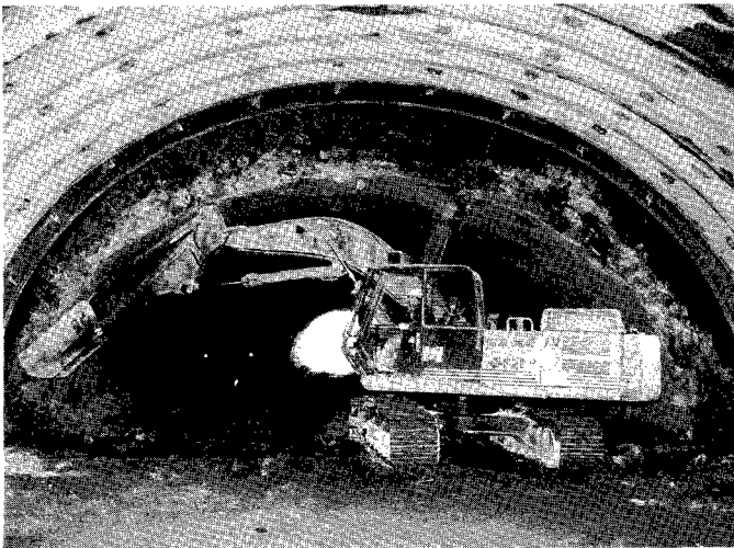
写真-1 縫い返し施工状況
