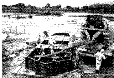
写真-2 コンクリート打設状況
