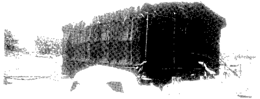
写真-1 雪寒仮囲い設置状況
