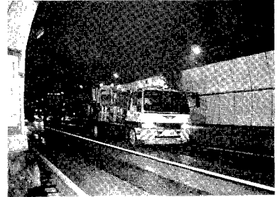
写真-1 トンネル清掃車施工状況(現状)
