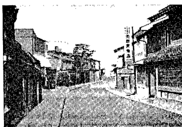
「より善くする」ための 修景写真
