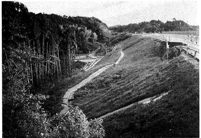
写真-1 地すべり災害状況
