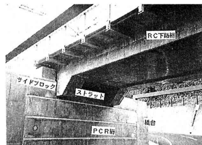
写真2 ストラット部
